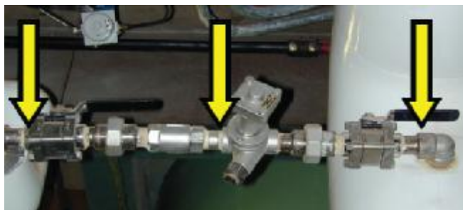
شکل ( 3 ) : نقاط موثر جهت تست اولتراسونیک در یک ایستگاه تله بخار
