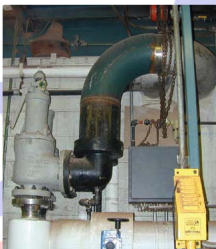
شکل (۲) : روش دیگری از لوله کشی خروجی شیر اطمینان به همراه ساپورت گیری های لازم
