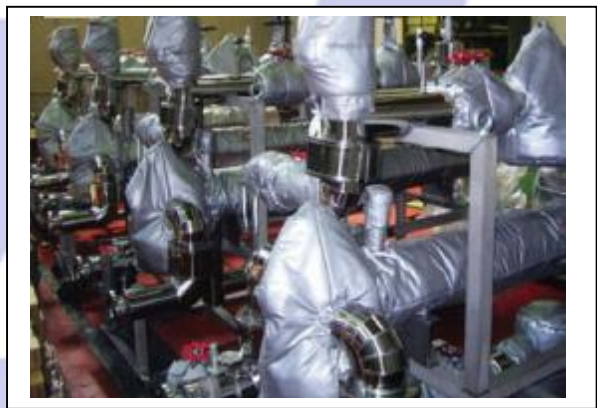
شکل 1: ژاکت بخار قابل باز و بسته شدن جهت نصب بر روی شیرآلات
