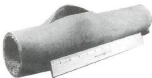
شکل 1: لوله ی شکافته شده ی بویلر
